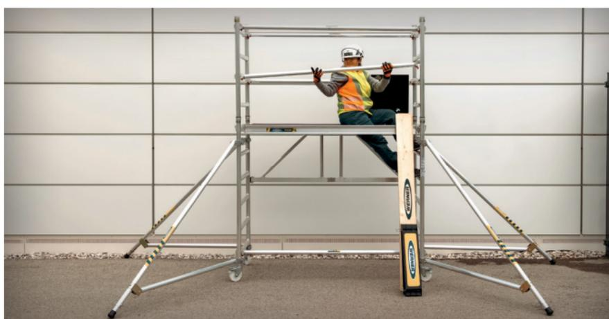
AUFBAU NACH 3T-METHODE (TROUGH THE TRAPDOOR) IM SITZEN DURCH DIE
